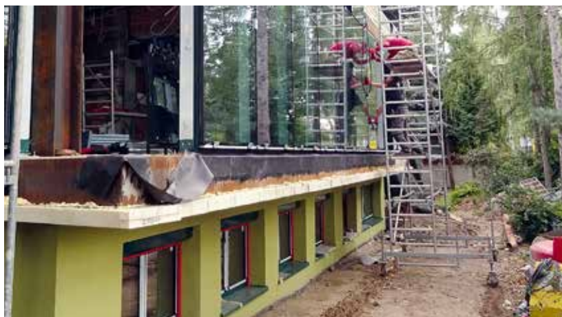
Na budowie praca w re
